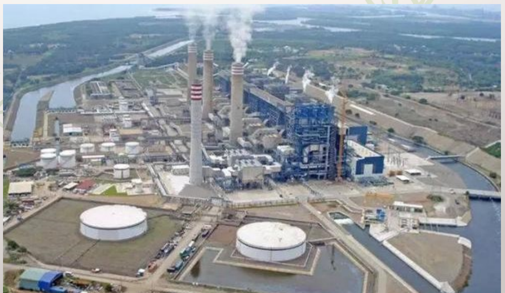
CENTRAL TERMOELÉCTRICA PRESIDENTE PLUTARCO ELÍAS CALLES, OPERADA POR LA COMISIÓN FEDERAL DE ELECTRICIDAD, TAMBIÉN CONOCIDA COMO CENTRAL PETACALCO.
